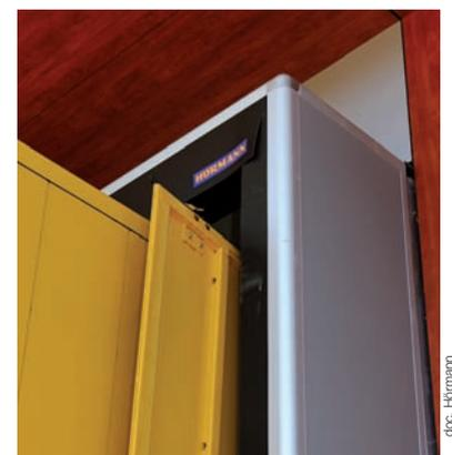
Gros plan sur l'habillage périphérique réalisé en panneaux d'acier de 20 mm d'épaisseur à isolation thermique.
